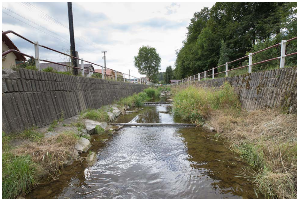
Obr. č. 3 Profil č.4, upravená časť koryta Vadičovského potoka. Foto: Peter Drengubiak Fig. 3. Mapping site No. 4, a regulated section of the Vadičov brook streambed. Photo: Peter Drengubiak
