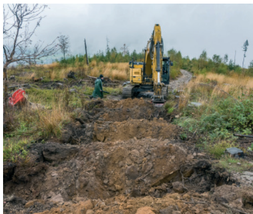
Obr. 3: Inovativní metoda jáma-hráz-jáma
